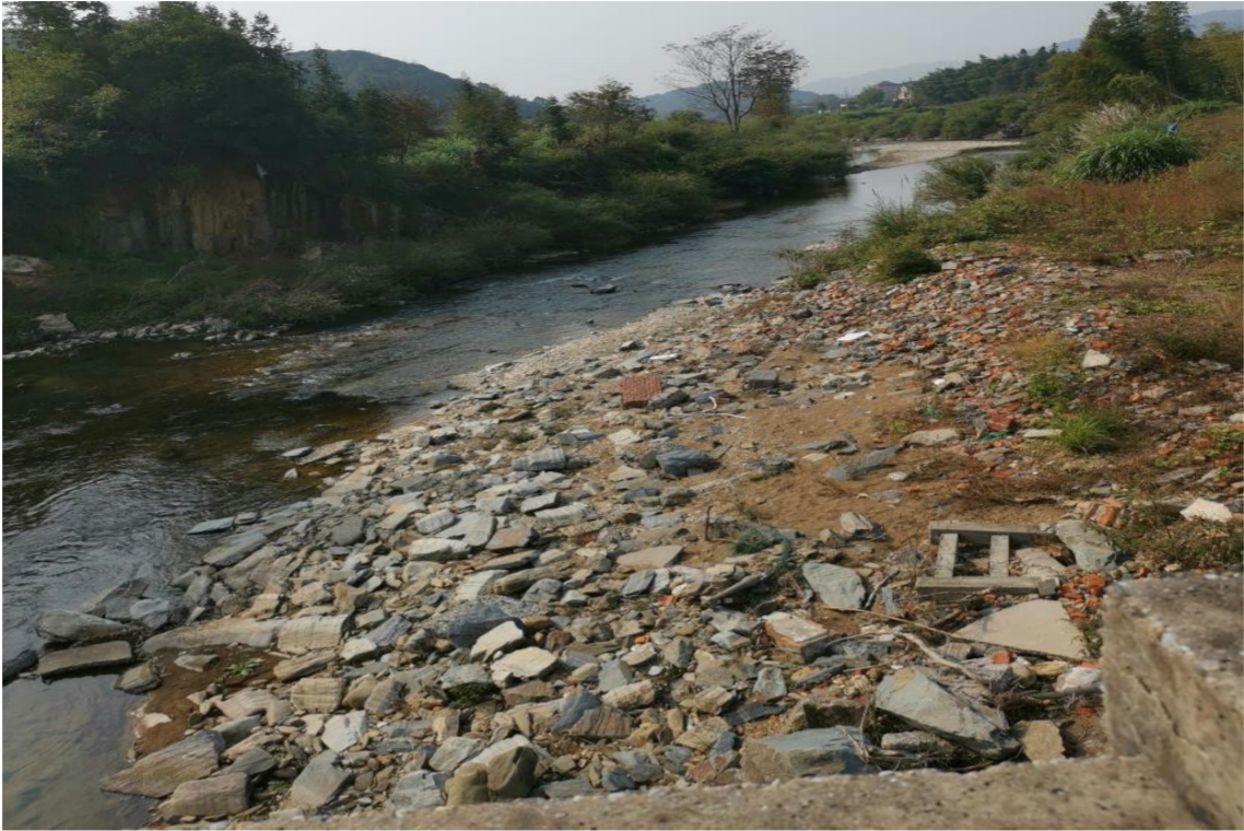
图 7.5-1 龙泉河利安段需清淤清障现状图
